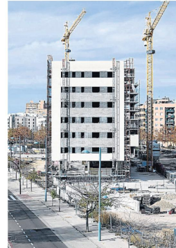
Obras en el barrio de Jesús. O. DUICH
